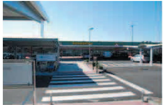
Itinerario peatonal de acceso a la terminal
