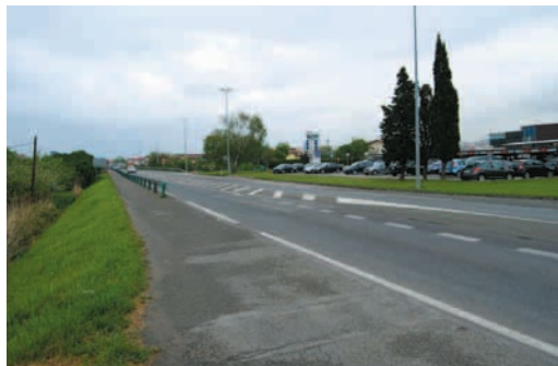
Entorno con elevado tráfico sin paso protegido
