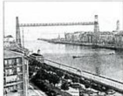
**PUENTE DE VIZCAYA.** Construido en 1893 por Alberto de Palacio, el Puente Colgante comunica las dos margenes del Nervión entre Portugalete y Las Arenas en un ancho de 160 metros. Ejemplo destacado de la arquitectura del hierro.
