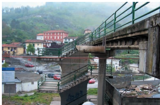
Familia santua: trenbideetara iristeko egokitu gabeko eskailera tartekak. Ez dago inolako segurtasun seinaleztapenik
