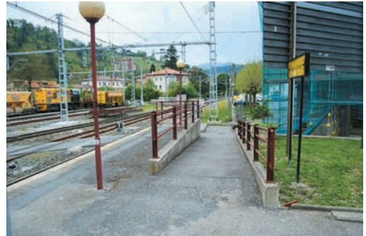
Karrantza: bertaratzeko arrapala egokitu gabe dago eta zoladura eskasekoa da
