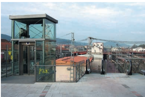
Irun: igogailuak eta eskailera mekanikoak instalatu dira geltokira iristeko Txanaleta plazatik
