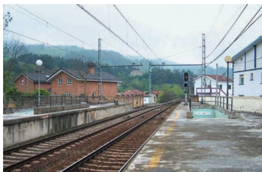
Putxeta: baldintza kaskarretan dagoen zoladura. Ez dago segurtasun seinaleztapenik
