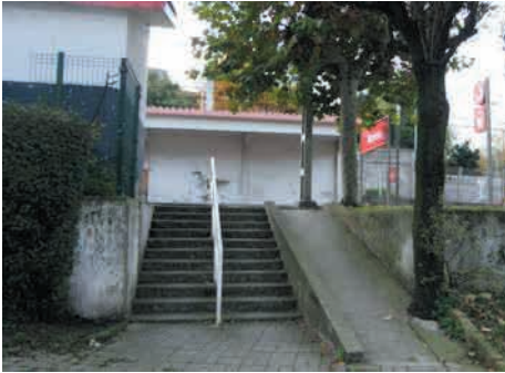
Ategorrieta: nasara iristeko egokitu gabeko sarbide arrapala. Malda malkartsua. Ibiltezina
