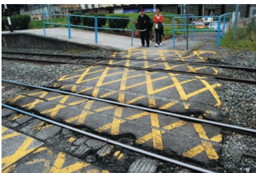
Ariz-Basauri: oso hondaturik dagoen eta oso arrisku- tsua den trenbide-pasagunea. Mailen arteko aldea duten zona zabalak, irregulartasunak direla-eta
