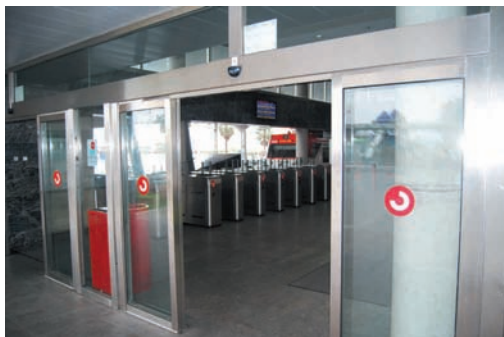
Santurtzi: seinaleztapeneko zerrenda horizontalik ez duen ate automatizatua
