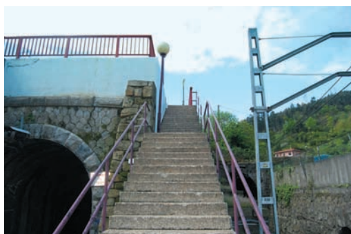
Kastrexana: nasarako sarbidea malda adierazgarriko eskailera tarte baten bitartez. Arriskutsua
