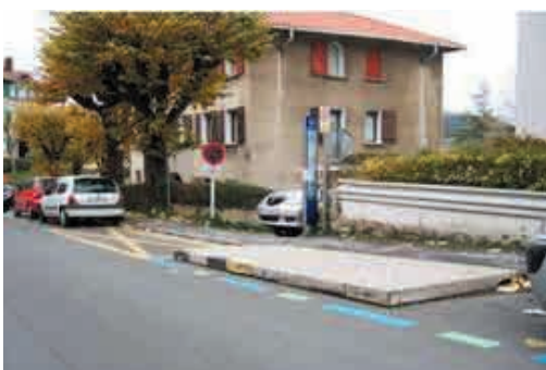
Espaloi plataforma, bertara iristeko arrapalarik gabe. Geralekua ez da irisgarria eta ezinezkoa da ibilgailura iristea
