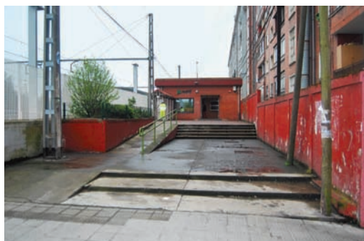
Zorrotza: eraikinerira iristeko arrapalak ez daude egokiturik. Ez dago eskubanda bi aldeetan. Zoladura irristakorra
