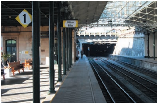
Bilbo-Konkordia: segurtasuneko seinaleztapenik gabe (zerrenda kromatikoa eta ukimen zoladura)
