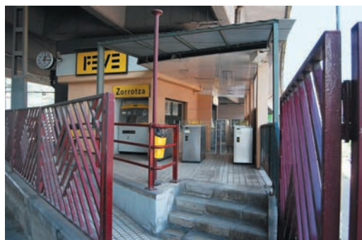
Zorrotza: nasara iristeko, egokitu gabeko eta maniobrak egiteko muga ugari dituen arrapala estu bat gainditu behar da
