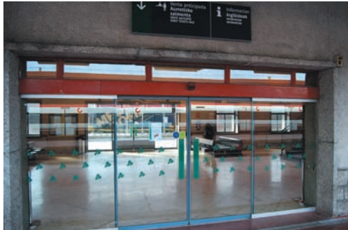
Seinaleztapen horizontala duten ate automatikoak
