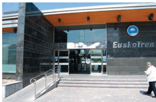
Lasarte-Oria: instalazioetara iristeko arrapala ibilgarria da, nahiz eta ez dagoen behar bezala egokituta. Ez dago eskubanda bi aldeetan. Behar beste toki dago zabalduagoak izateko
