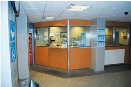
Bermeo: atenditu gabeko eta egokitu gabeko salmahaia (ez dago garaiera gutxiagoko tarterik, ezta sakonera egokiko zokorik ere)
