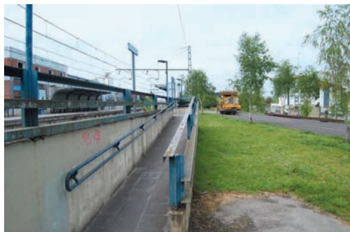
Kurtzea-Lezama: nasara iristeko egokitu gabeko arrapala. Arrapala maniobrak egiteko aukera gutxi ematen duen eremu batean amaitzen da, eta, gainera, ibilbidearen amaieran zutoin bat dago maniobrak egitea mugatzen duen oztopo gisa
