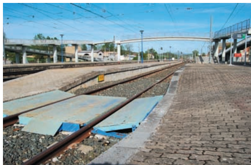
Dulantzi: trenbide-pasagunea egoera kaskarrean, irtengune eta peralte arriskutsuekin
