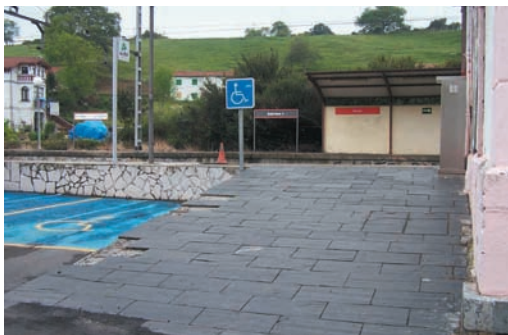
Putxeta: nasara iristeko arrapala ez dago egokiturik eta akastuna da. Zoladura irristakorra
