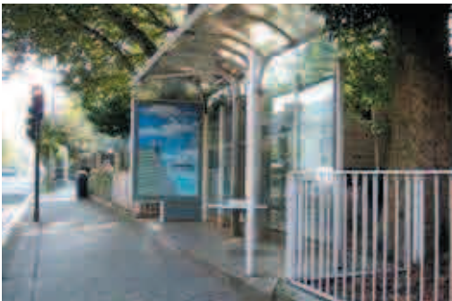
Marquesina ubicada sobre escalón de 15 cm de altura. Inaccesible
