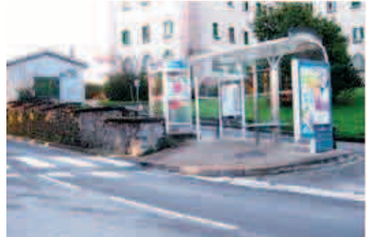
Pendiente excesiva para acceder a la parada
