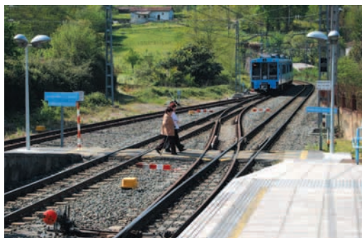
Usansolo-Galdakao: paso a nivel con resaltes. Rampas carentes de protección y pasamanos en ambos lados
