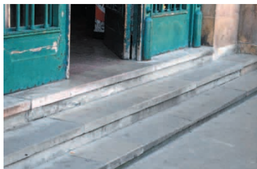
Llodio: el acceso se realiza a través de un tramo de escaleras y escalones en la entrada del vestíbulo
