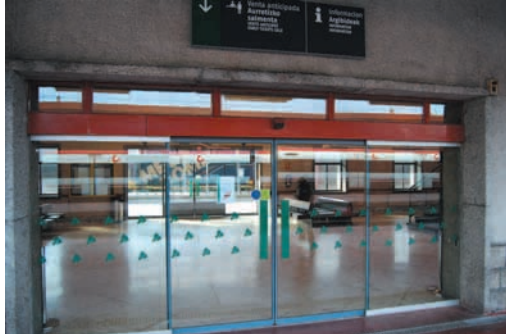
Puertas automáticas con señalización horizontal
