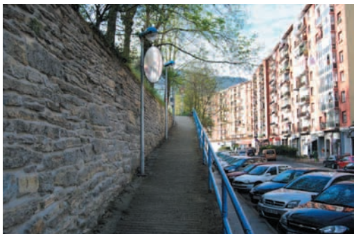
Ermua Errotabari: rampa de acceso al apeadero no acondicionada. Pendiente muy pronunciada. Acera estrecha con vehículos en batería
