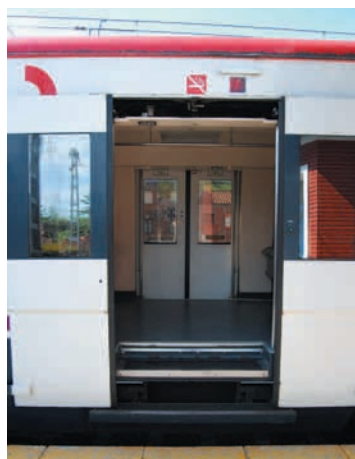
"Gap" vertical de separación andén-tren
