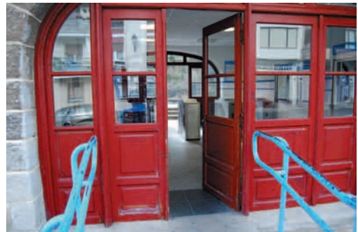
Mundaka: puerta de acceso estrecha. Ambas hojas deben permanecer abiertas
