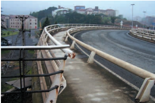
Galindo: el entorno peatonal de acceso al equipamiento discurre paralelo a una calzada de tráfico intenso. La acera tiene una pendiente pronunciada
