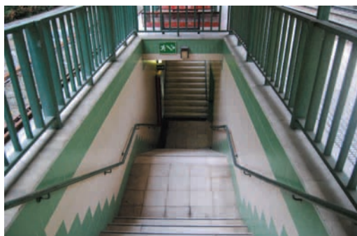
Ollargan: paso subterráneo entre andenes sin pasamanos a doble altura en ambos lados del recorrido
