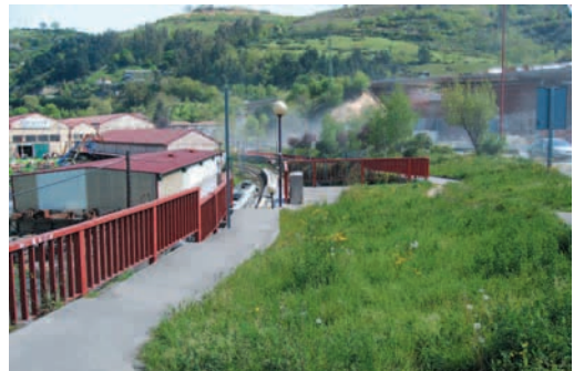
Castrejana: acceso deficiente con tramos de escalones y escaleras pronunciadas
