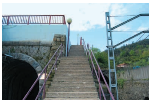
Castrejana: acceso al andén a través de un tramo de escaleras de pendiente pronunciada. Peligroso
