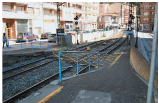
Berriz: rampa pronunciada de acceso al andén Barandilla de protección sin pasamanos en ambos lados. Obligado recorrido previo a través de las vías
