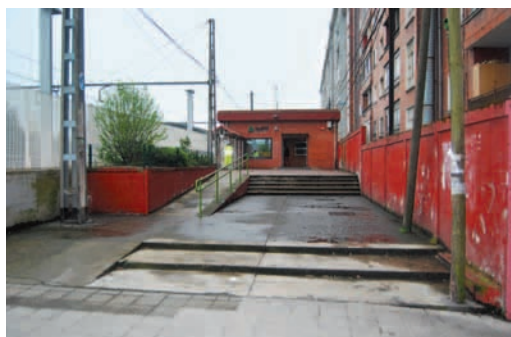
Zorrotza: las rampas de acceso al edificio no están acondicionadas. Carentes de pasamanos en ambos lados. Pavimento resbaladizo
