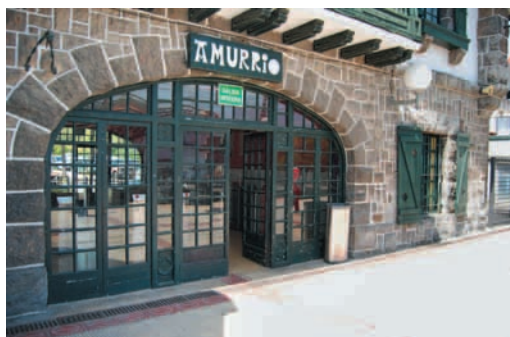
Amurrio: puertas estrechas de acceso. Necesario que ambas hojas estén abiertas para facilitar el tránsito hacia el interior
