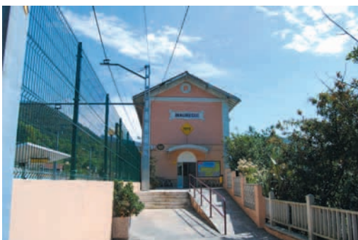
Irauregi: rampa con peralte y pendiente pronunciada. (hay espacio para alargar la rampa). Barandilla protectora en el lateral sin pasamanos
