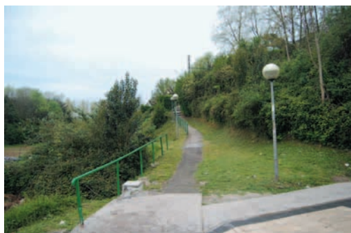
Hernani: rampa de pendiente pronunciada. Paso subterráneo poco funcional para las personas con movilidad reducida
