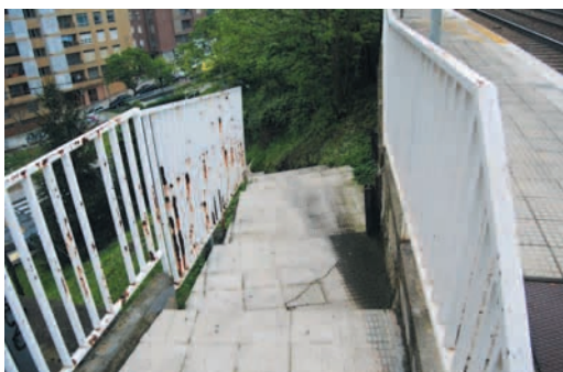
Ollargan: tramos de escaleras sin acondicionar para acceder a la estación
