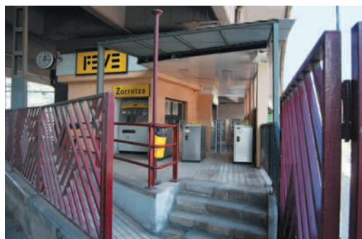
Zorrotza: acceso al andén a través de rampa estrecha no acondicionada y de muy limitada maniobrabilidad
