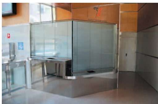
Taquilla adaptada. Dispone de un tramo acondicionado a menor altura
