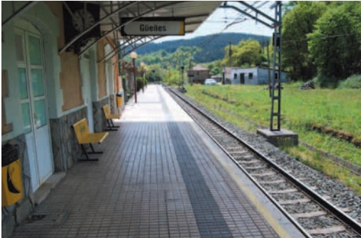
Modelo de pavimento habitual en las estaciones del corredor de FEVE
