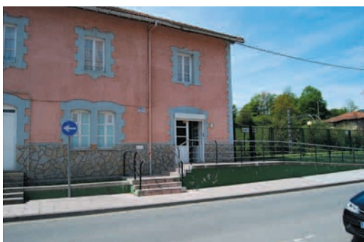
Güeñes: puerta de acceso al vestíbulo estrecha. No permite el paso de una silla de ruedas, salvo que ambas hojas están abiertas
