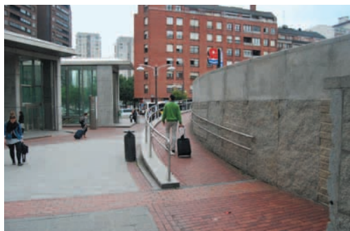
Rampa de acceso desde el Intercambiador de transporte. Su disposición en curva complica la subida de la persona con movilidad reducida
