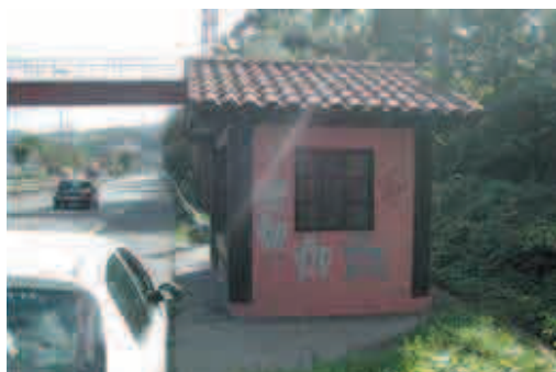
Sin acera para acceder. Peligroso
