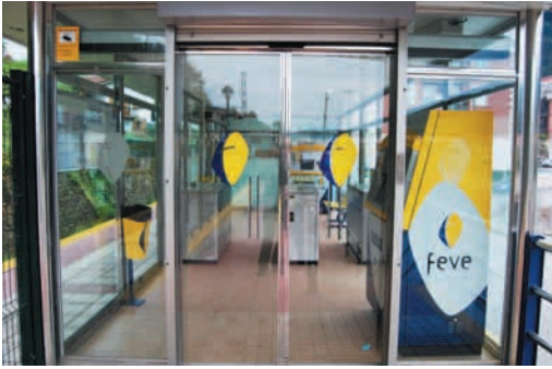
La Calzada: estación reformada. Sin banda horizontal de señalización de marcado contraste cromático
