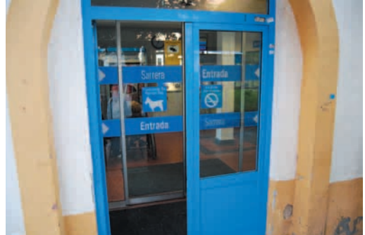
Ermua: puertas de doble hoja en el acceso. Imprescindible que ambas estén abiertas
