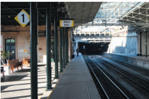
Bilbao-La Concordia: sin señalización de seguridad (banda cromática y pavimento táctil)
