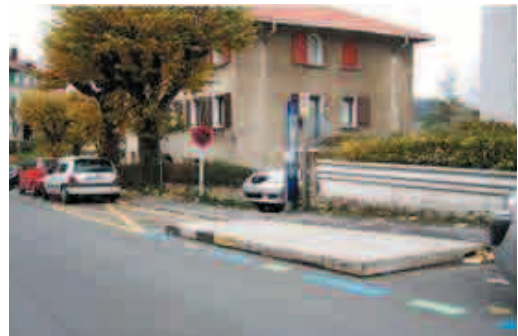
Plataforma de acera sin rampa de acceso. Inaccesible la parada e imposibilidad de acceder al vehículo
