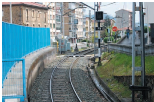
Zamudio: paso obligado de superficie para el acceso al andén
