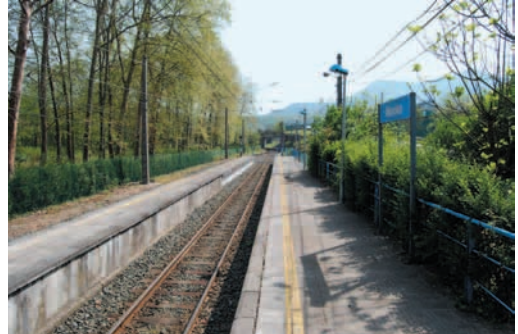
Muxika: apeadero próximo a la costa carente de elementos básicos de confort y seguridad
