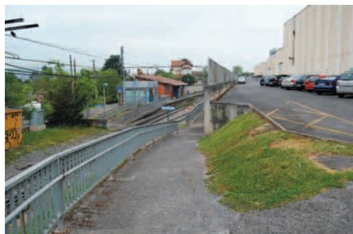
Larrondo-Loiu: entorno industrial. Acceso peatonal complicado. Pendiente muy pronunciada sin pasamanos de asistencia y pavimento en mal estado
