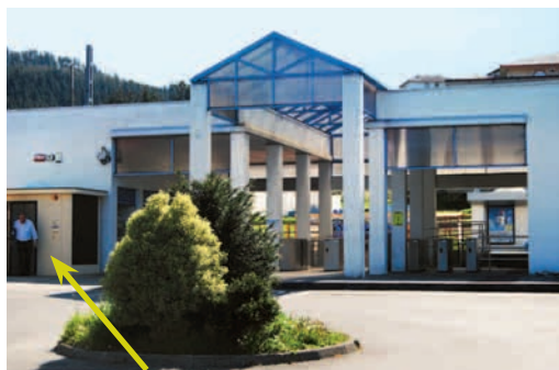
Usansolo: aseo adaptado en el exterior de la estación
