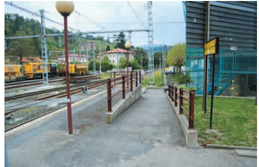
Carranza: rampa de acceso sin acondicionar y con pavimento deficiente
