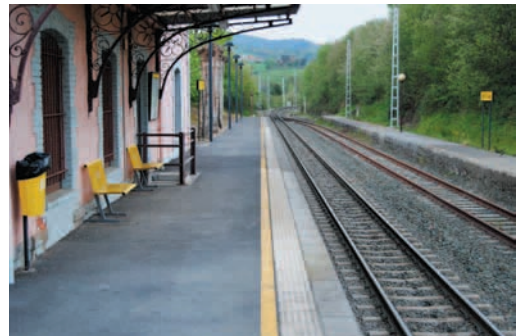
Villaverde de Trucios: edificio cerrado. Sin acceso al vestíbulo de espera
