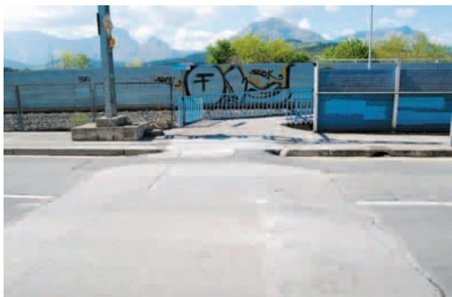
Traña: entorno industrial. Tráfico de vehículos pesados. Aceras estrechas con pavimento deficiente
