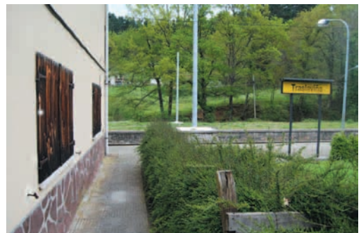
Traslaviña: edificio cerrado. El acceso al vestíbulo de espera se realiza por un lateral no acondicionado
