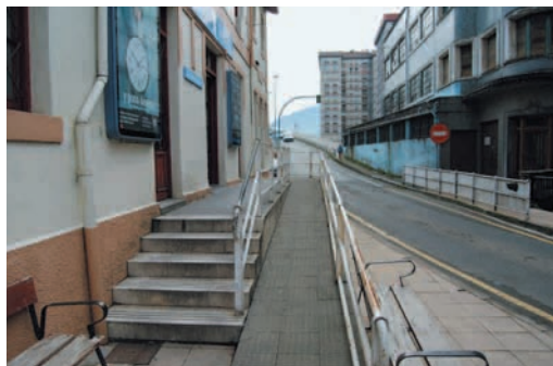
Eibar: rampa complementaria de acceso. Los pasamanos deberían estar presentes en todo el recorrido. El extremo sin barandilla protectora resulta peligroso
