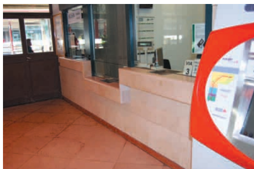
Irun: mostrador de atención con tramo a menor altura. No tiene hueco inferior de suficiente profundidad
