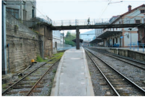
Eibar: andén estrecho. Circulación peligrosa
