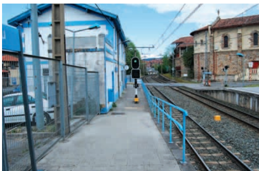
Zuhatsu-Galdakao: paso a nivel en estado deficiente en el desplazamiento entre andenes. Obstáculo en el acceso al andén desde el vestíbulo
