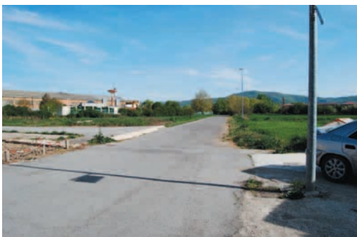
Alegria-Dulantzi: calzada de acceso a la estación sin itinerario peatonal (acera) complementario
