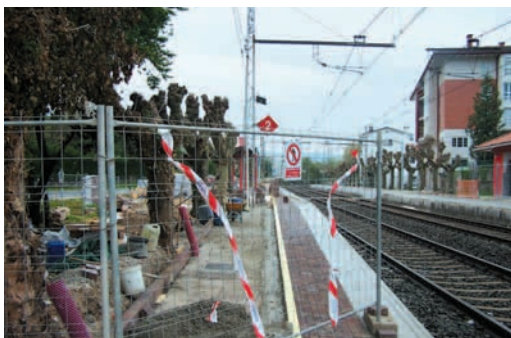
Urneta: acondicionamiento de andenes a las CIVIA
