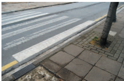
Peñota: acera no rebajada en el paso de cebrada de acceso a la estación
