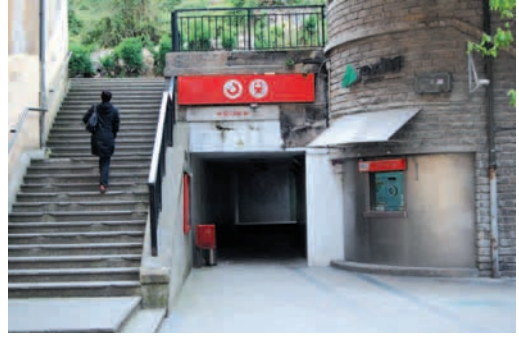
Tolosa centro: estación de gran demanda (>1.000 personas/día). Inaccesible
