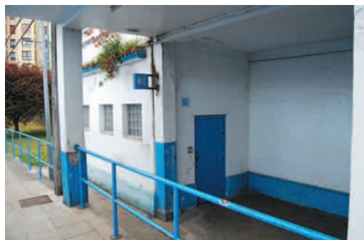
Bermeo: aseo no adaptado en la propia estación
