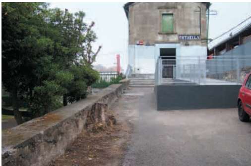
Ortuella: la llegada a la rampa precisa de un itinerario peatonal previo a través de una cuesta de pendiente pronunciada y pavimento con irregularidades
