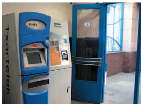
Belaskoenea Irun: puertas estrechas de acceso que condicionan el tránsito de las personas con movilidad reducida
