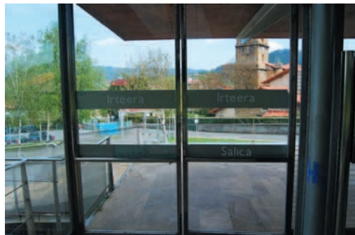
Lezama: puertas de acceso al vestíbulo cerradas. Pesadas en su movimiento
