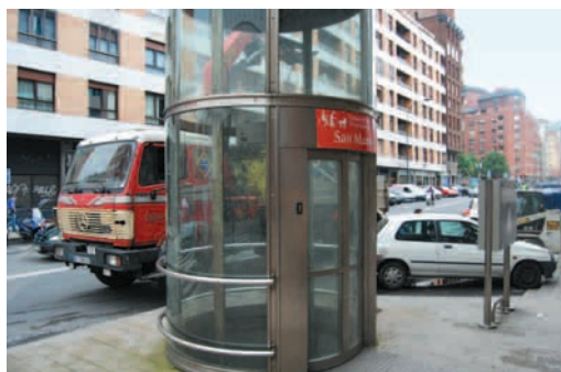
Ascensor de entrada al vestíbulo en San Mamés
