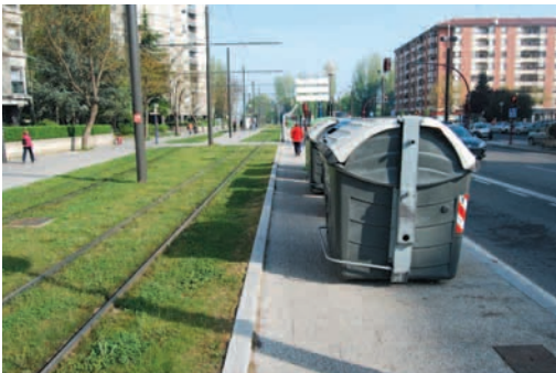
Obstáculos en el itinerario peatonal de acceso
