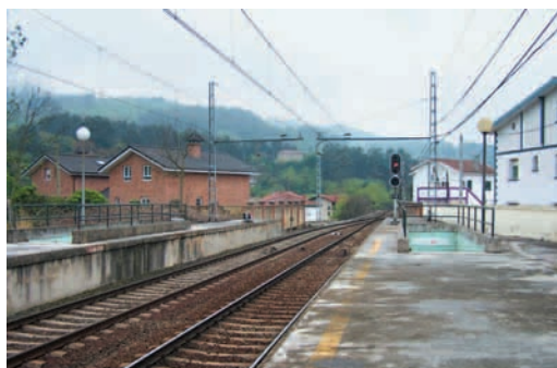
Putxeta: pavimento en estado deficiente. Sin señalización de seguridad
