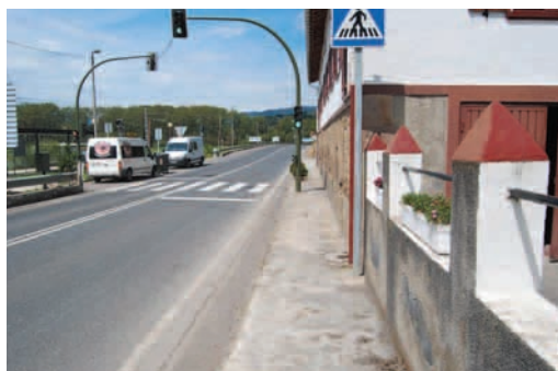
Artxube: acera estrecha con pavimento en mal estado. No protegida de la calzada. Tráfico intenso
