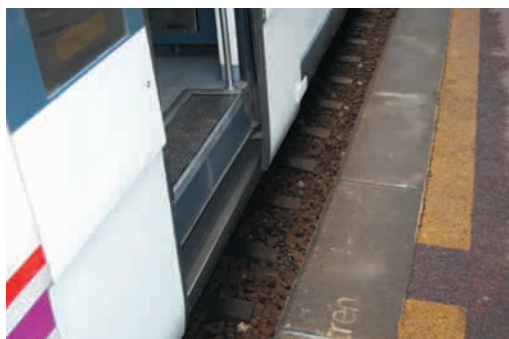
"Gap" horizontal de separación andén-tren
