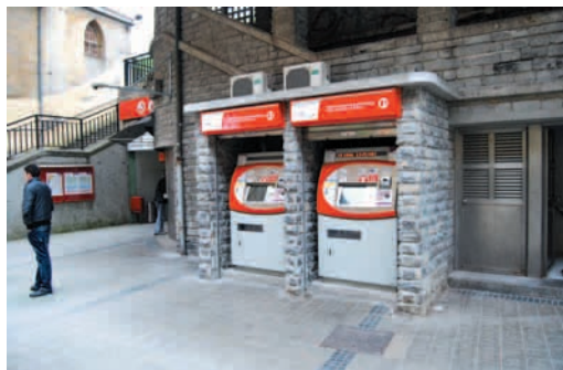
Ubicación inadecuada. Sobre un escalón
