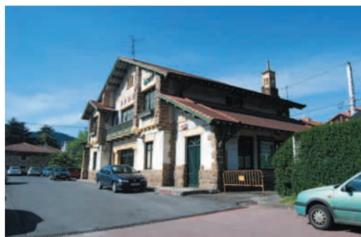
Arrigorriaga: estación ubicada en un alto. El itinerario peatonal de acceso desde la calle incluye escaleras, por un lado, y cuesta de larga pendiente por el otro
