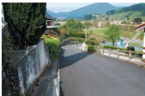
Forua: acceso de pronunciada pendiente sin acera de protección. Priorizado para vehículos particulares
