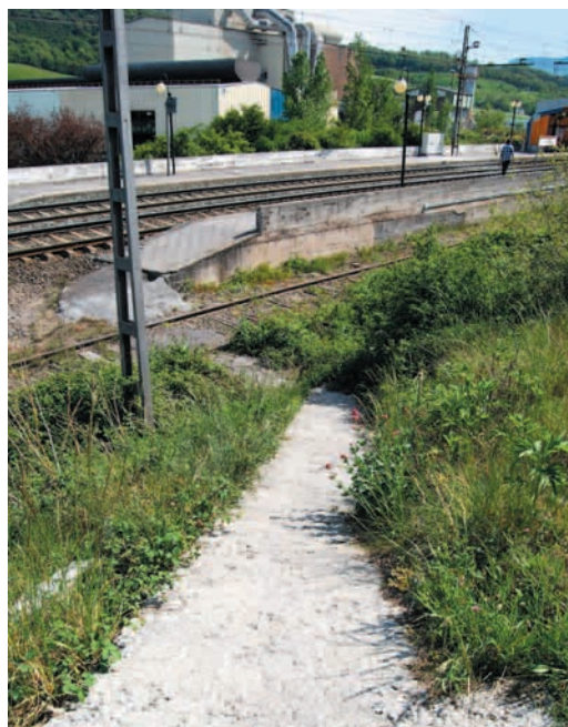
Iñarratxu: acceso a través de senda no acondicionada con pendiente pronunciada. El otro acceso se realiza a través de tramos de escaleras sin acondicionar
