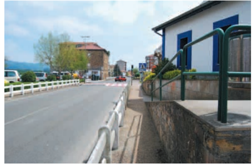
Zamudio: acera estrecha junto a calzada de tráfico intenso. Rampa de acceso no acondicionada
