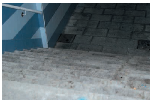
Olabeaga: tramo de escaleras para acceder desde la calle al equipamiento
