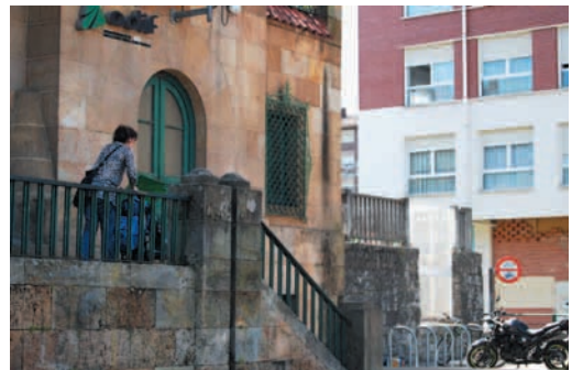
Llodio: acceso al edificio a través de tramos de escaleras y escalones en la entrada
