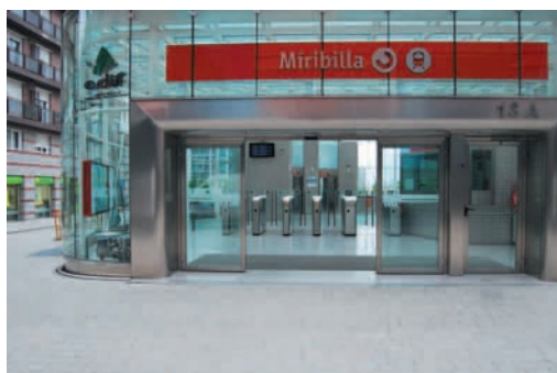
Miribilla: Puertas automáticas con bandas de señalización
