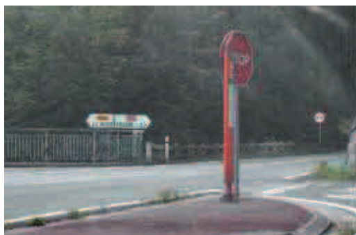
Parada ubicada en cruce de carreteras. Sin entorno peatonal protegido. Peligroso
