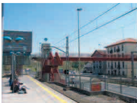
Rekalde: el entorno peatonal de la estación discurre por una zona de intenso tráfico
