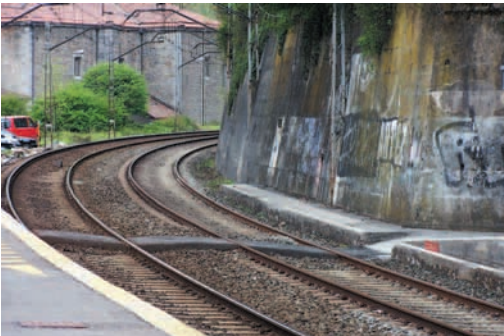
Alegia: la disposición del paso a nivel es especialmente peligrosa por encontrarse la estación en curva
