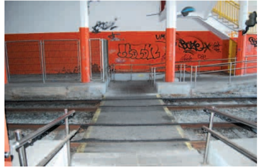
Irun Colón: paso a nivel entre andenes en la ruta de acceso alternativa
