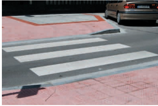
Amurrio-Iparralde: itinerario peatonal exterior con franjas podotáctiles de información y aviso para personas con discapacidad visual
