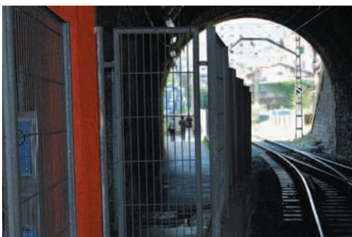
Irún centro: el recorrido alternativo de acceso a la estación no resulta practicable. Obliga a cruzar un paso a nivel en deficiente estado de conservación
