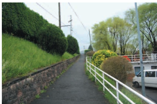
Andoain: rampa de acceso no acondicionada. Pendiente muy pronunciada
