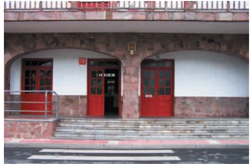
Muskiz: paso de cebrá no rebajado. Acera estrecha para acceder a la rampa de entrada
