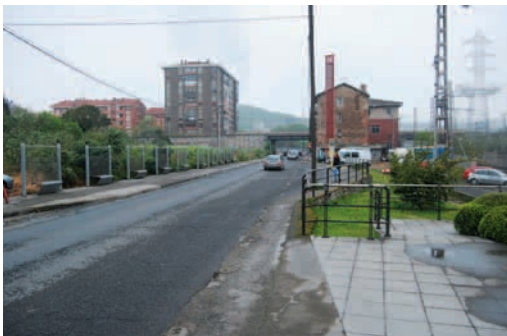
Lutzana: entorno industrial. Importante tráfico de vehículos pesados. Aceras estrechas sin protección y con pavimento deficiente
