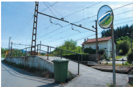
Arbide: rampa no acondicionada de acceso al andén. Pendiente y peralte excesivo
