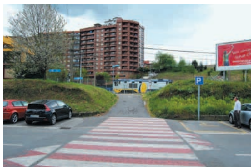
Ariz-Basauri: rampa no acondicionada de acceso al apeadero. Pendiente pronunciada
