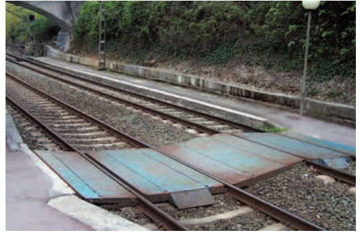
Martutene: paso a nivel complicado y con pavimento resbaladizo
