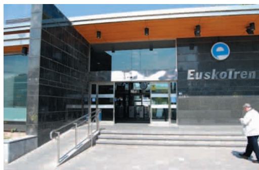
Lasarte-Oria: la rampa de acceso es practicable, aunque no está debidamente acondicionada. Carece de pasamanos a ambos lados. Hay espacio suficiente para que sea más tendida
