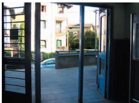
Loiola: puertas estrechas que no facilitan el tránsito de la persona con movilidad reducida en silla de ruedas. Ambas hojas deben permanecer permanentemente abiertas
