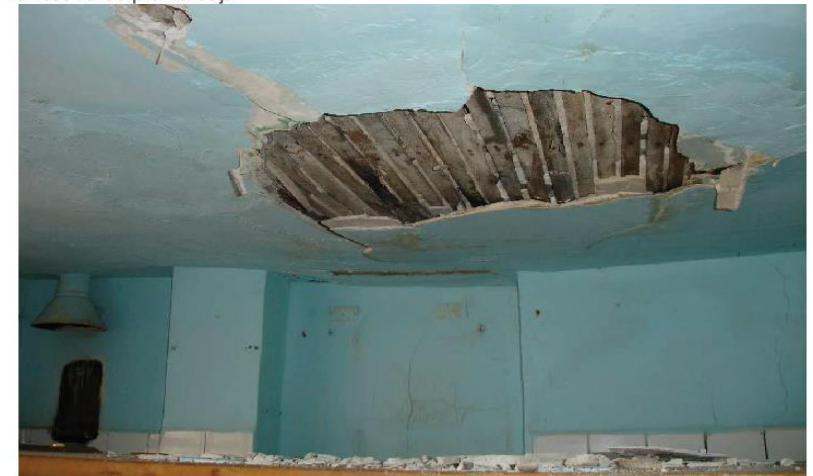
Desprendimiento de revestimiento de techos debido a flexión excesiva de estructura portante. Grandes desniveles en encuentro de pared con techo.
