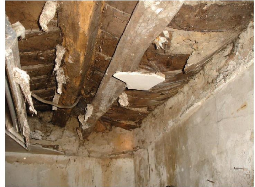
Pérdida de sección y torsión de elementos estructurales y hundimiento de tarima en techo de planta baja
