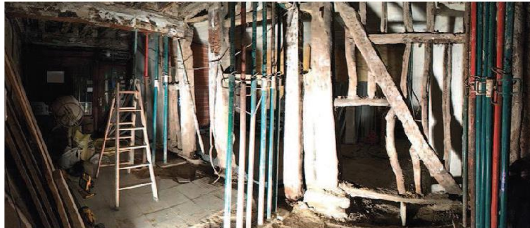
Apuntalamiento de emergencia en local de planta baja.
